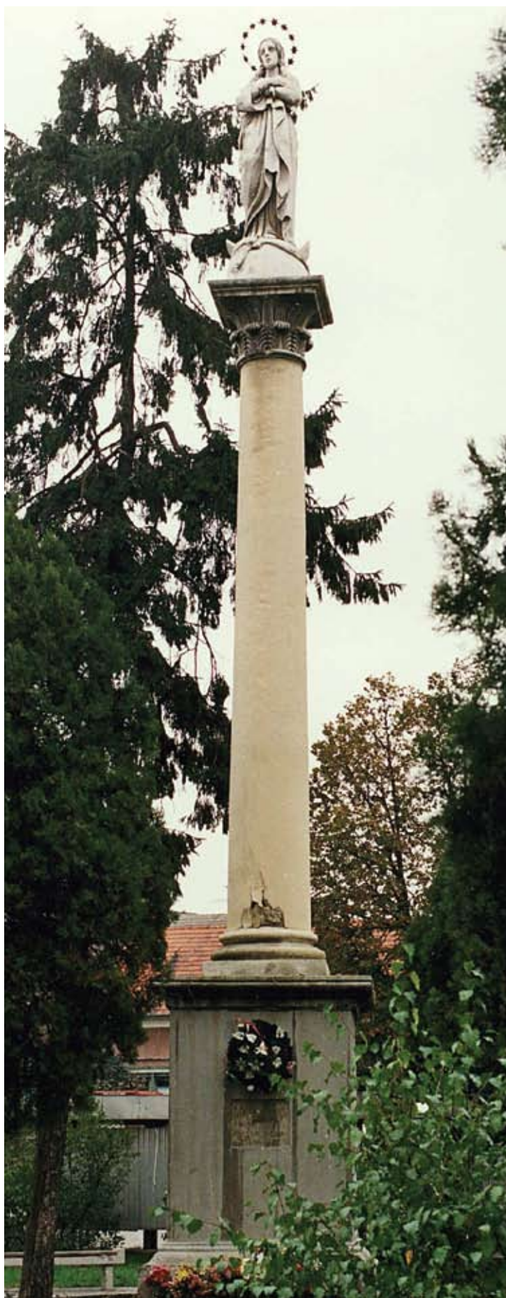
stav pred reštaurovaním / restaurálás előtt
