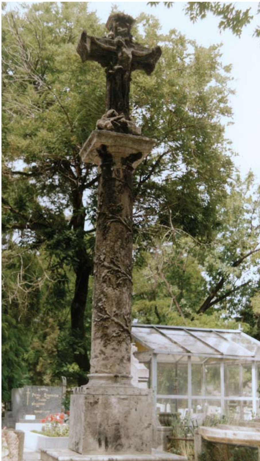
stav pred reštaurovaním / restaurálás előtt
