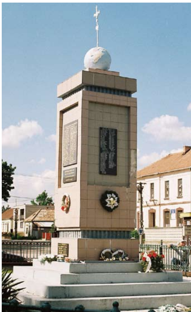
stav pred reštaurovaním / restaurálás előtt
