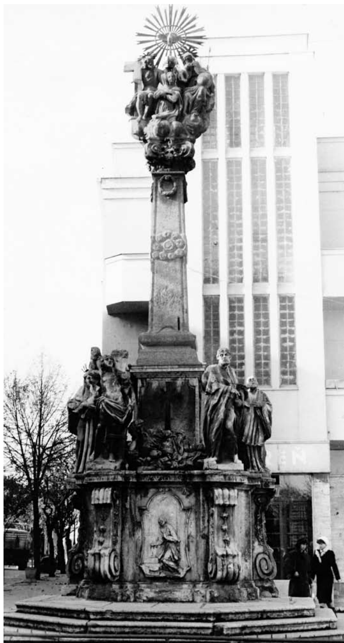
stav pred reštaurovaním / restaurálás előtt
